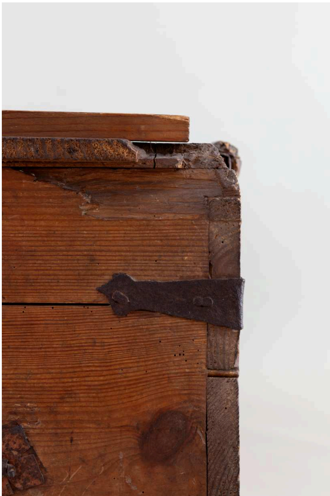
Stav před restaurováním - pravý bok, detail poškození
