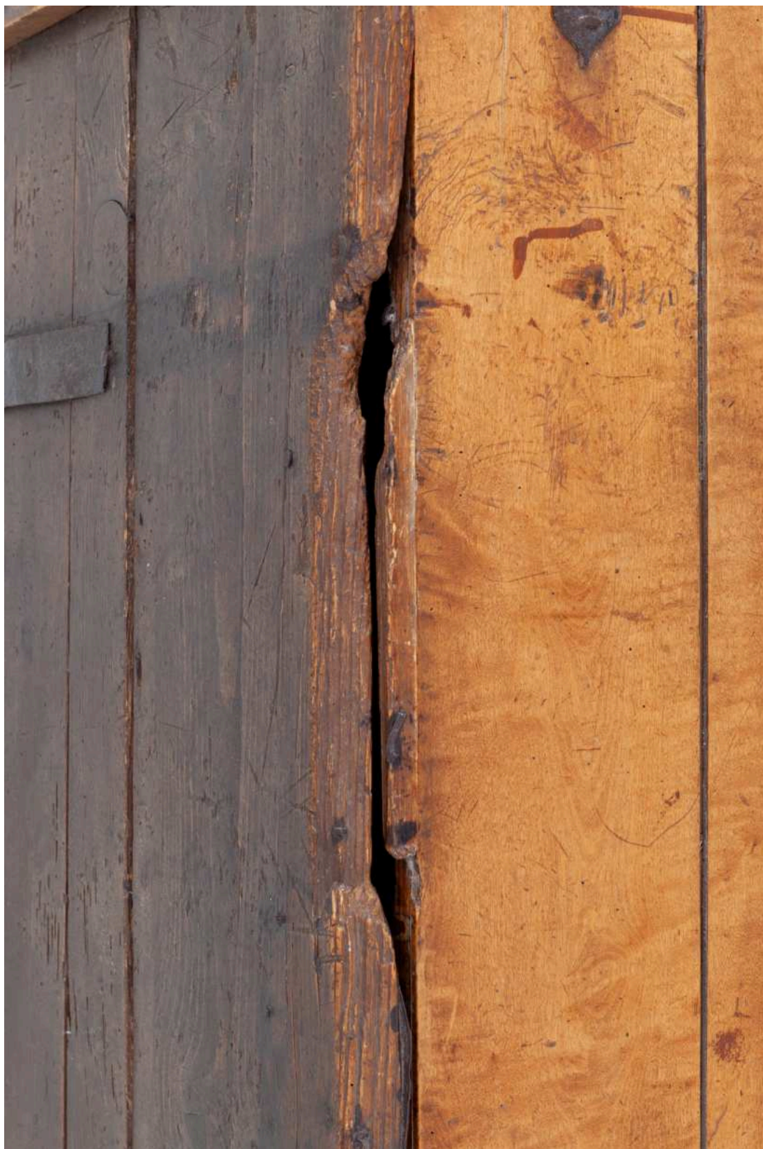
Stav před restaurováním - detail poškození víka
